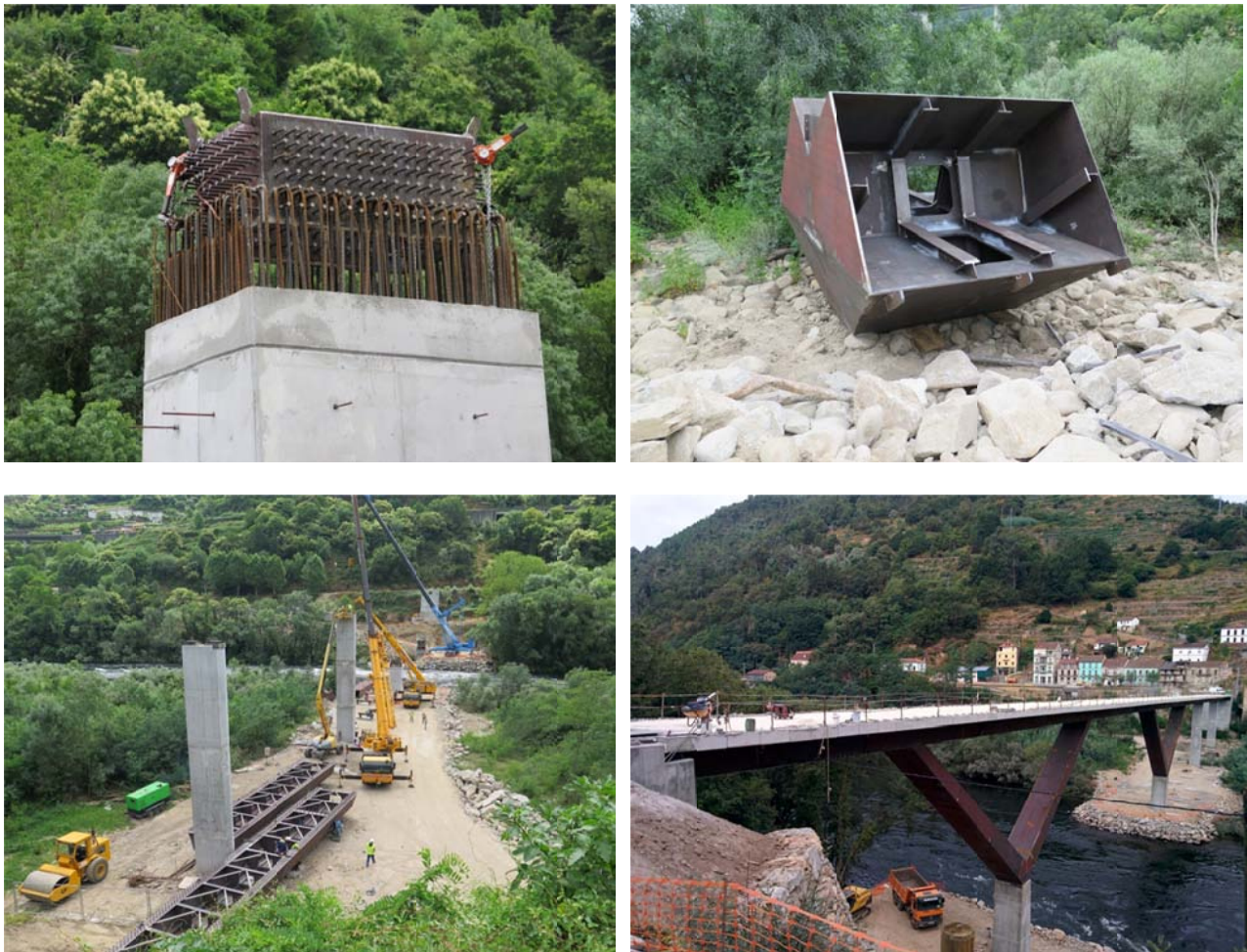
Figura 10 . Ejecución de la obra
